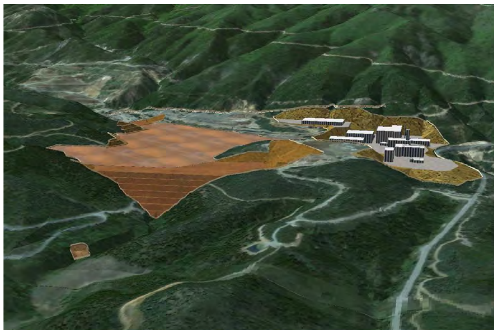
Σχήμα 6.9.1-3. Κατάσταση τοπίου περιοχής Στρατωνίου κατά τη φάση λειτουργίας του εργοστασίου μεταλλουργίας και μονάδας θεικού οξέος
